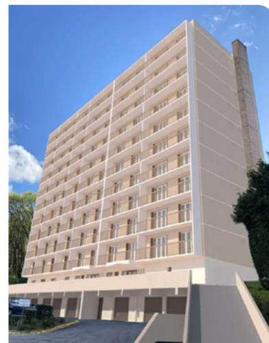
Projet de rénovation énergétique, Lyon 9e
