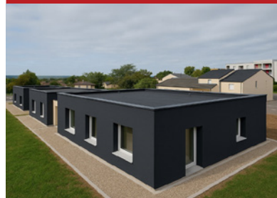
Logements de fonction du collège de St-Avold
